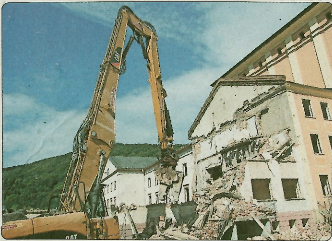
Mit dem Abriss des Kulturhauses in Suhl beginnt der Neu- und Umbau zum „Haus der Wirtschaft“.
