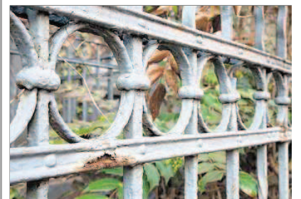
Rost entsteht, wenn ungeschütztes Metall mit Sauerstoff und Feuchtigkeit in Berührung kommt. Foto: Kai Rennmers
