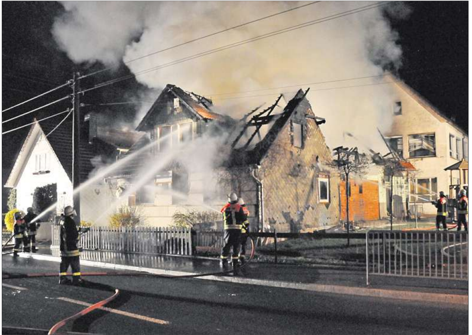
Wohngebäude und Nebengelass wurden in Sachsenbrunn ein Opfer der Flammen. Ein benachbartes Haus sowie die Grundschule sind arg in Mitleidenschaft gezogen.
