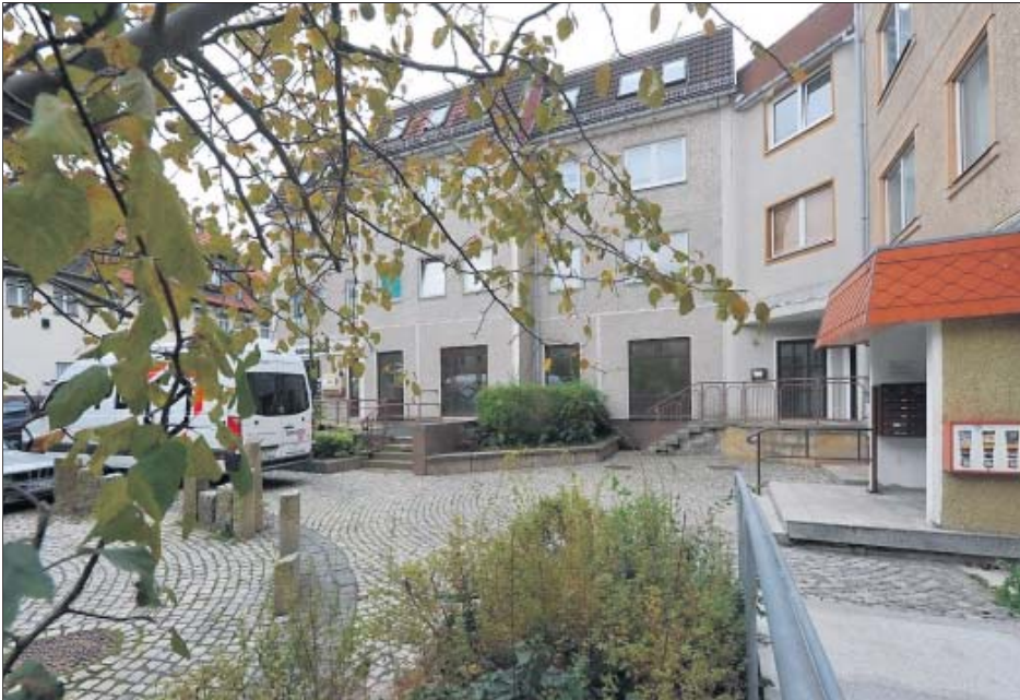
In die leer stehenden Geschäfte am Lilli-Platz zieht bald Leben ein, sie werden zu behindertengerechten Wohnraum umgebaut.
